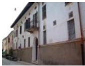
Palazzo Federici Sabbioneta (Mantova)
