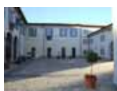
Palazzo Municipale Locali Archivio Carugate (Milano)
