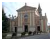
Chiesa di Vallalta Vallalta (Modena)
