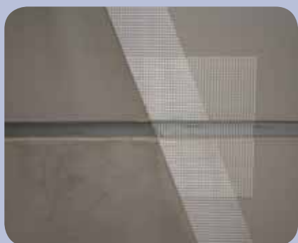
Rete di armatura per risega a trapezio.
